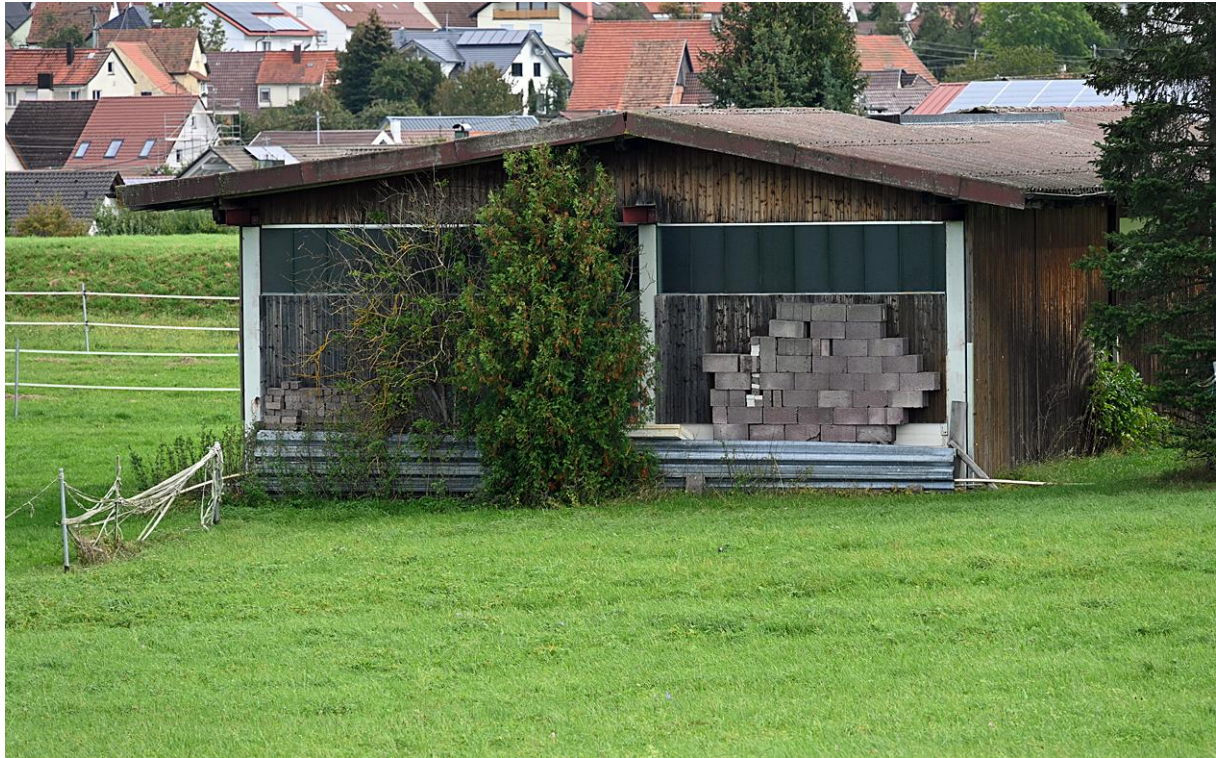
Abbildung 2: Ein südöstlich des Geltungsbereiches befindlicher Schuppen mit gewissem Quartierpotenzial.
